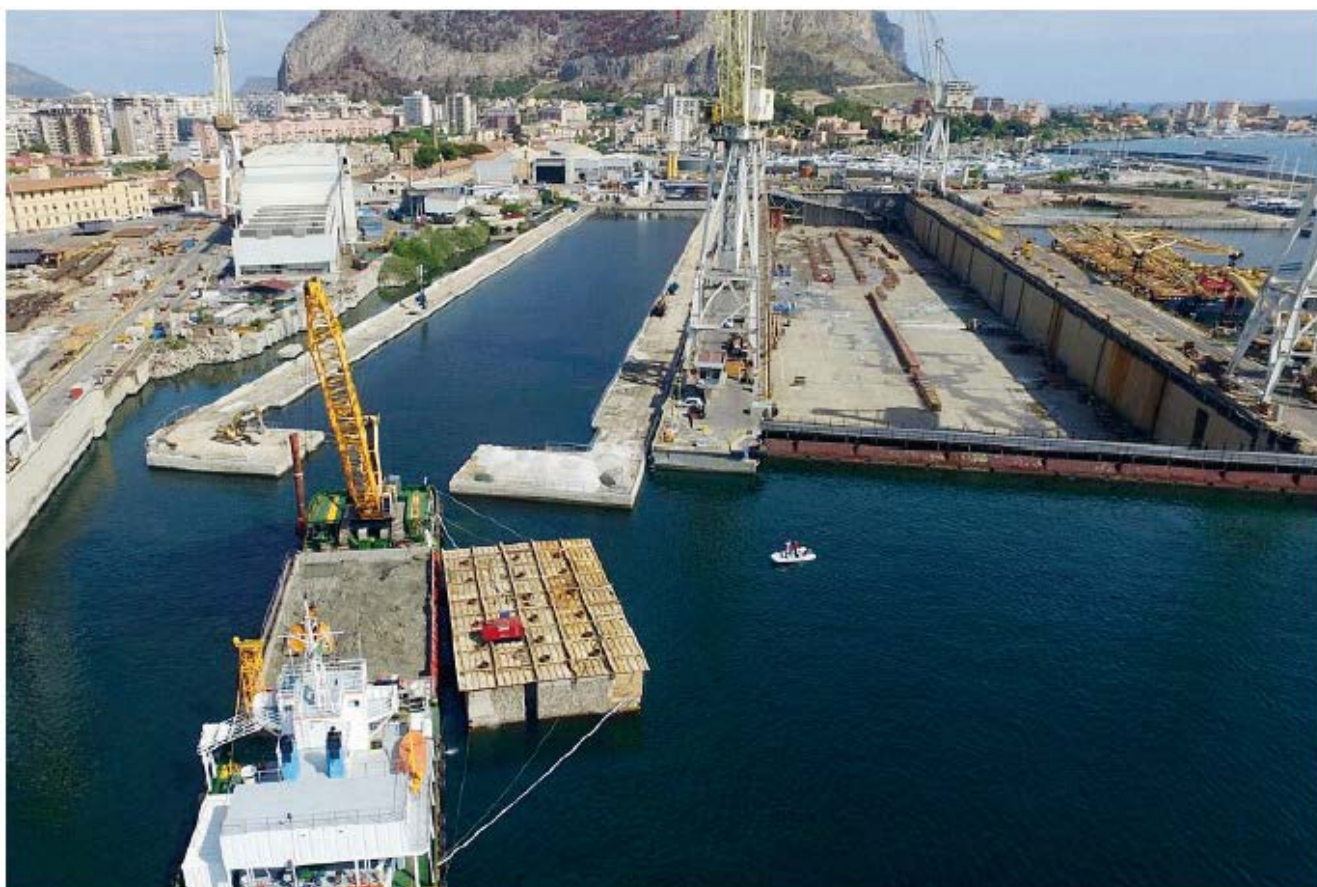
Veduta aerea del bacino di carenaggio da 150 mila tonnellate in ristrutturazione
